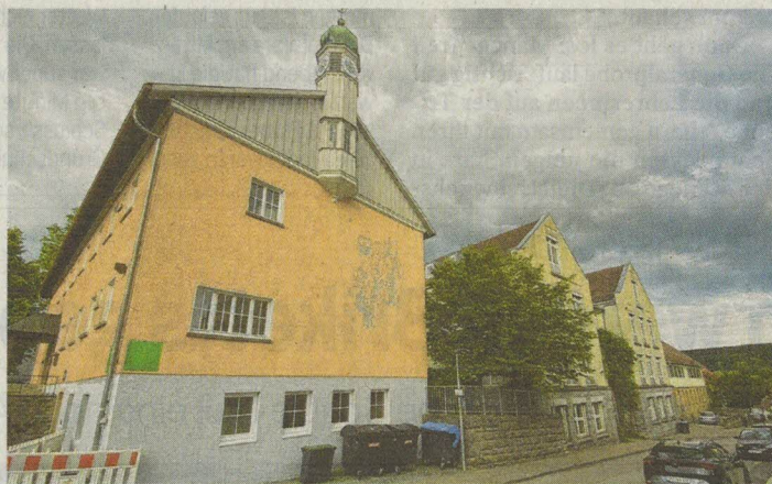
Der Gemeinderat votiert dafür, dass die Gebäude mitten in Hessental saniert werden, aber auch ein Neubau entsteht. Foto: Tobias Würth
